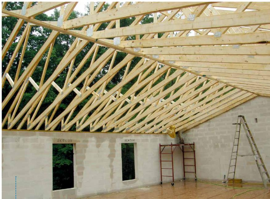
柱脚凸起的木质屋顶桁架
