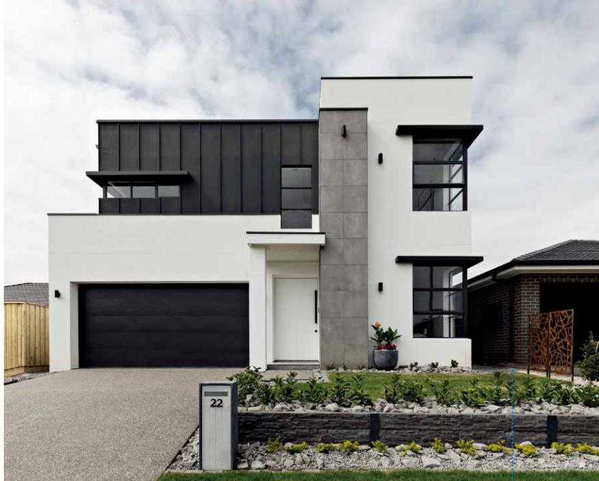
Hebel PowerProfile系统为立面提供了一个现代选项，可以复制传统金属立缝的外观
