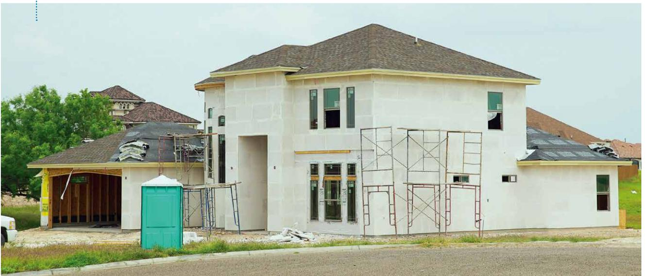
性能也很重要，安装好涂胶板并用螺钉将其与房屋框架连接后，房屋的结构完整性可得到保障。由于面板是用螺钉固定在螺柱上的，这使得整个房屋结构得到了加固。”
