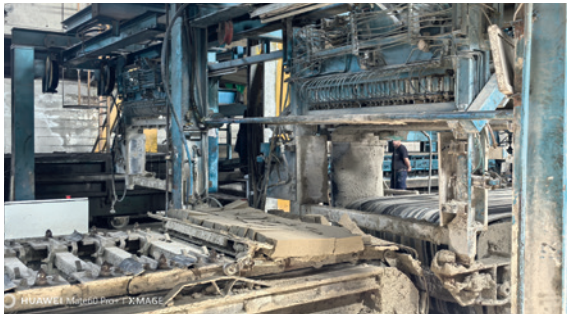
老旧低效的水平坯体切割系统
