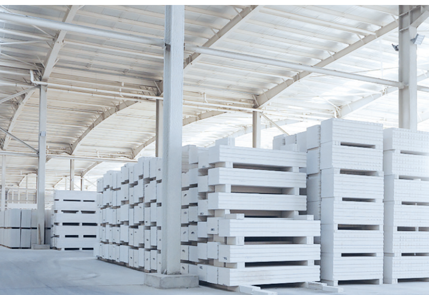
陕西凝远项目成品堆场
