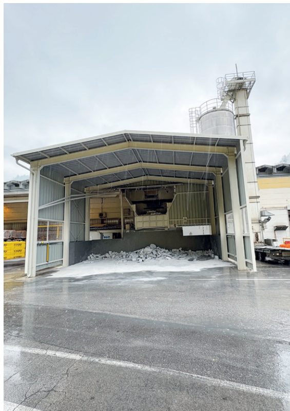
新的副产品生产大棚使工厂能够将以前归类为废料的材料进行研磨，并直接重新投入生产过程
