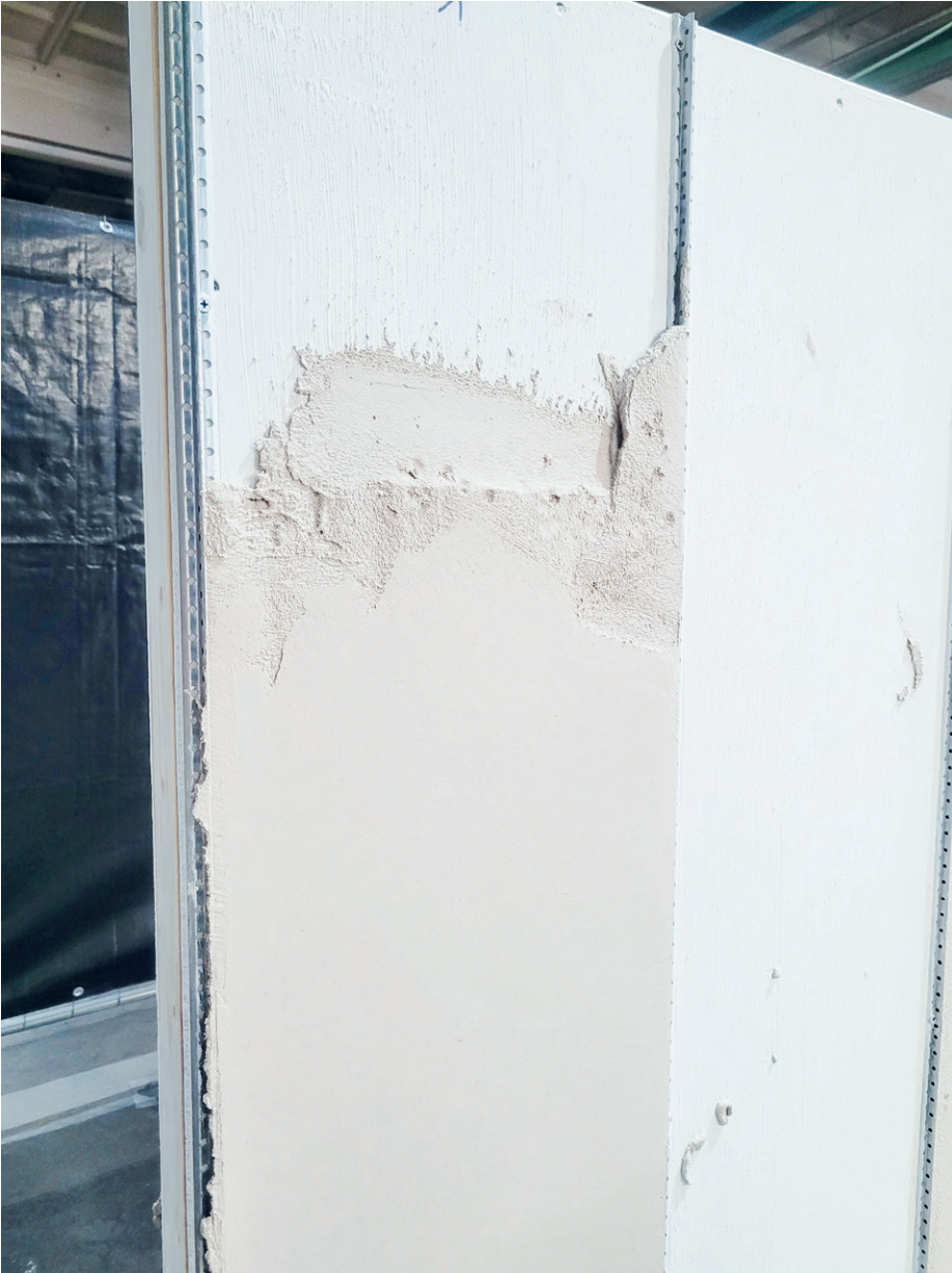
图 4: 掺入 55% (质量分数) 加气混凝土粉末的轻质石膏基建筑抹灰的试验性施工
