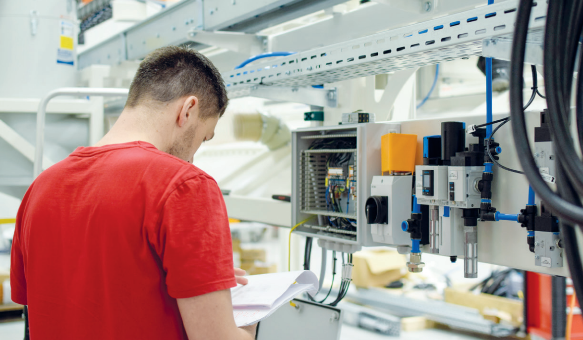
图 5: 调试期间对电气和气动控制系统的检查
