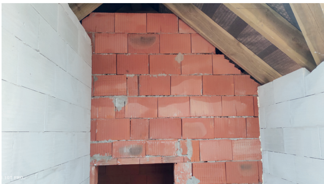
对比鲜明：高精度AAC 墙体与陶瓷砖墙
