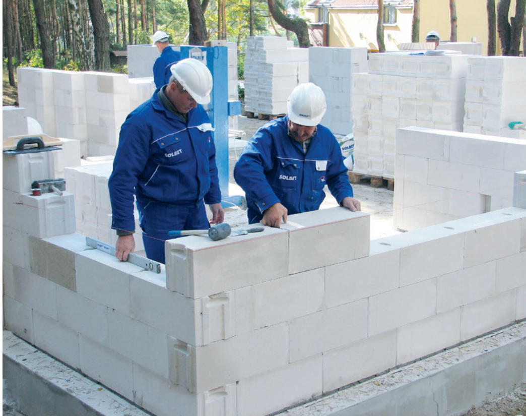
精细施工的AAC墙体
