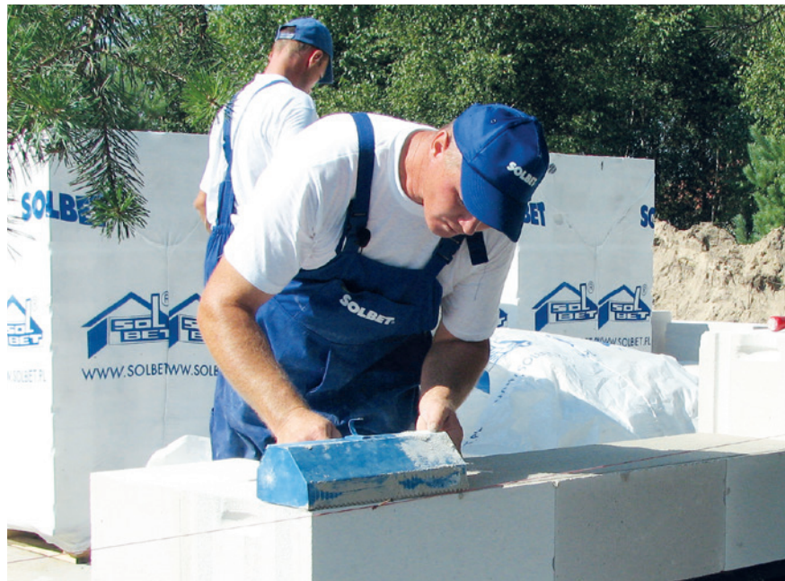
薄层砂浆粘结高精度AAC砌块
