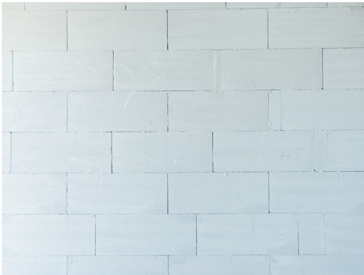
无缝隙砌筑的AAC墙体完全均质化的解决方案
