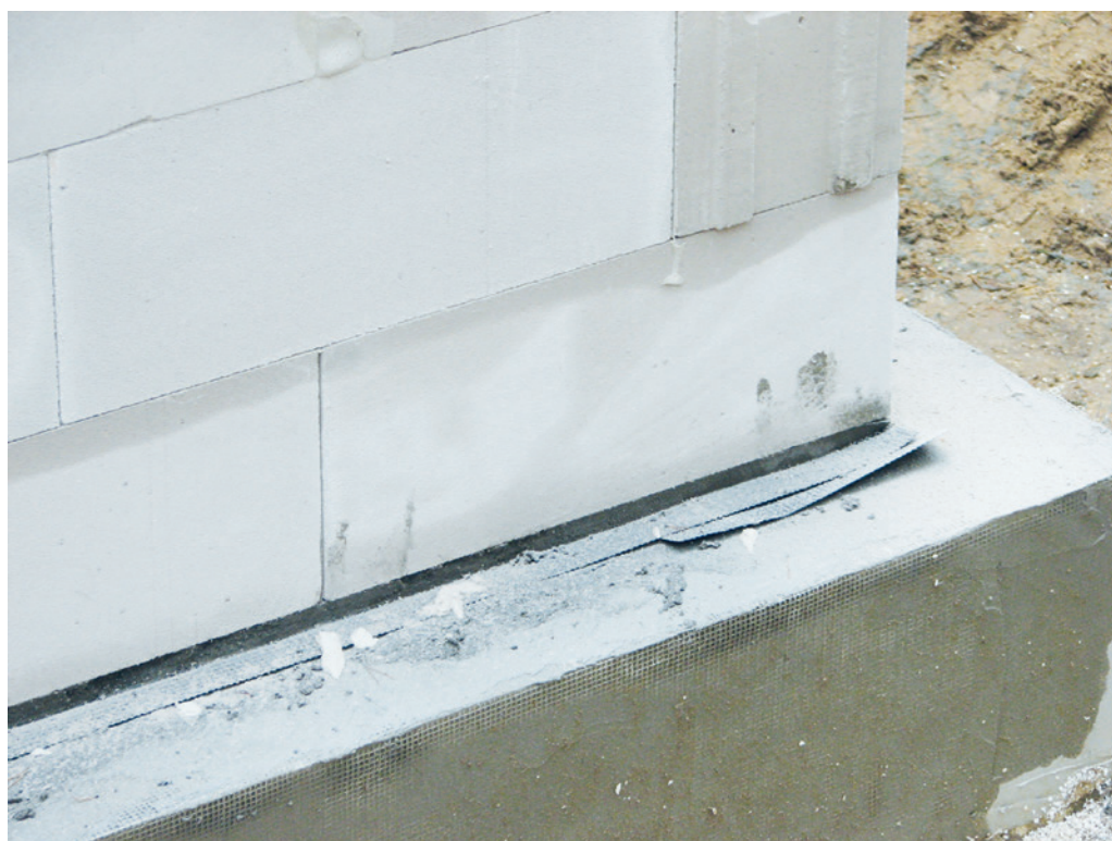
常规水泥砂浆用于 砌块首层找平
