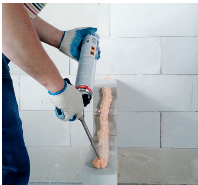
聚氨酯粘合剂仅适用于高精度砌块（AAC及抛光粘土砌块）
