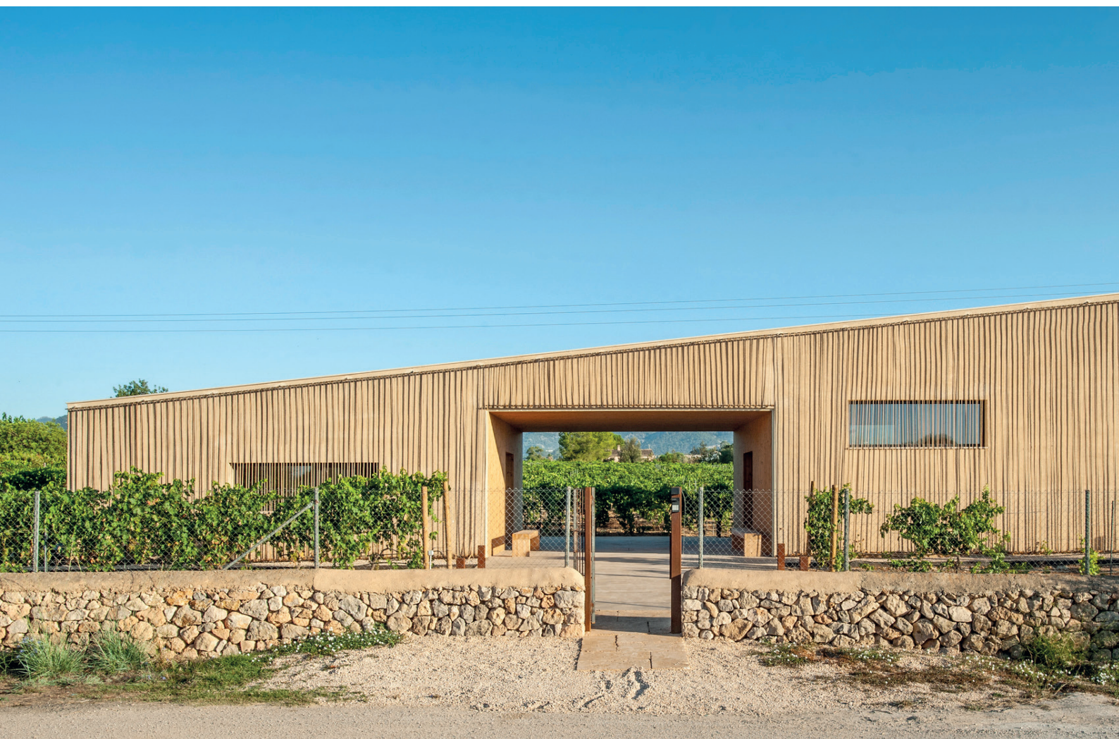
酒庄选用伊通加气混凝土砌块建造，该材料具有环保低碳、卓越热惰性及高效节能特性
