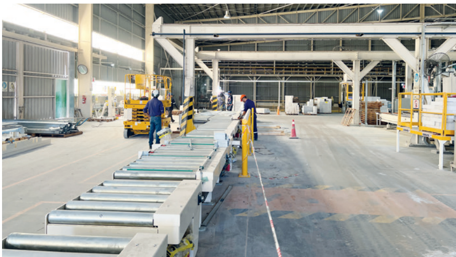
图10：安装用于板材卸载的附加输送线
