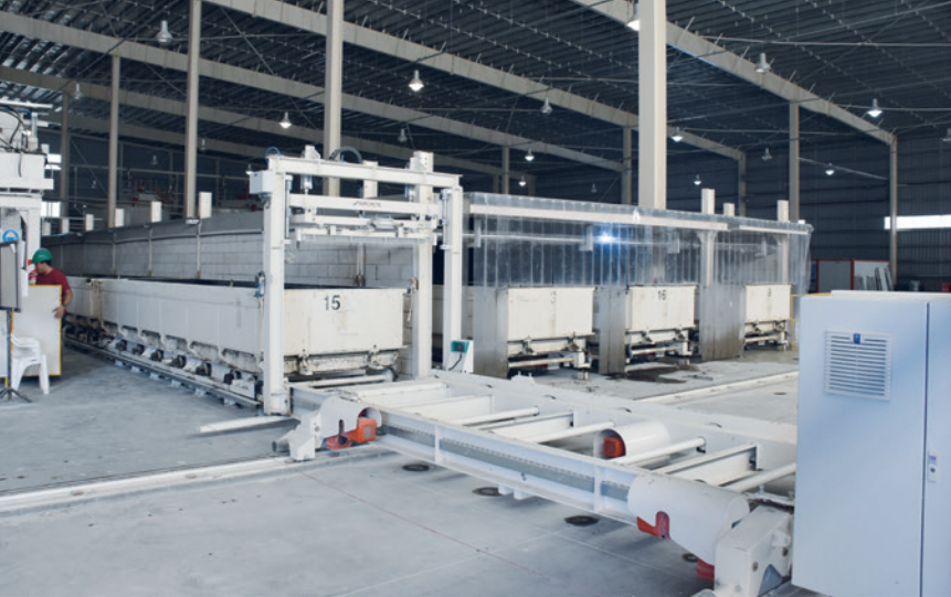
图3：封闭预养区域的视图
