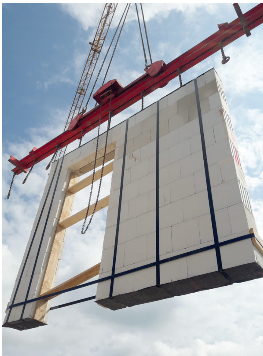
使用Rimatem-Vario运输系统安全组装模块化墙体
