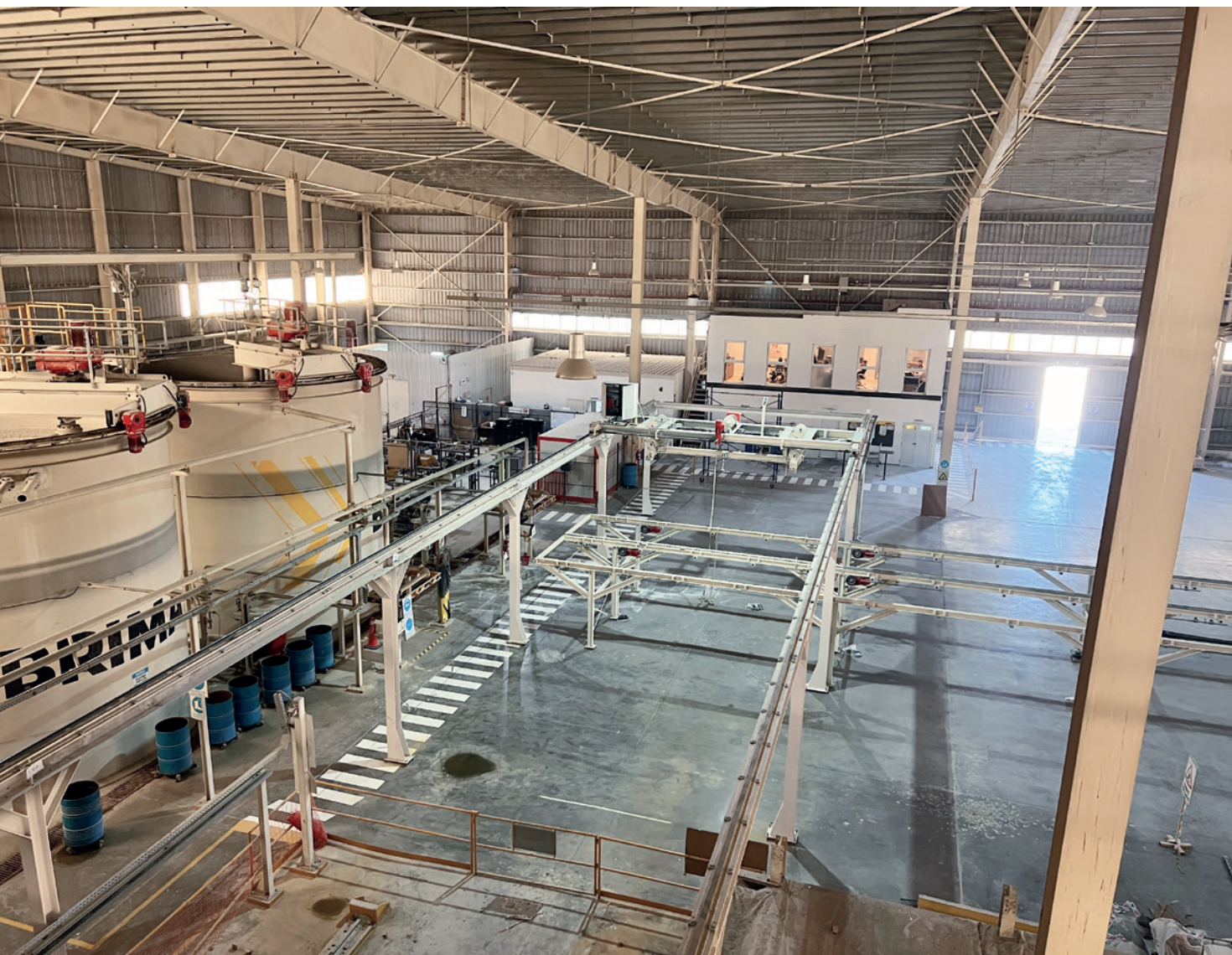
图4：已安装钢筋天车轨道架，钢筋天车位于最远后方的末端位置
