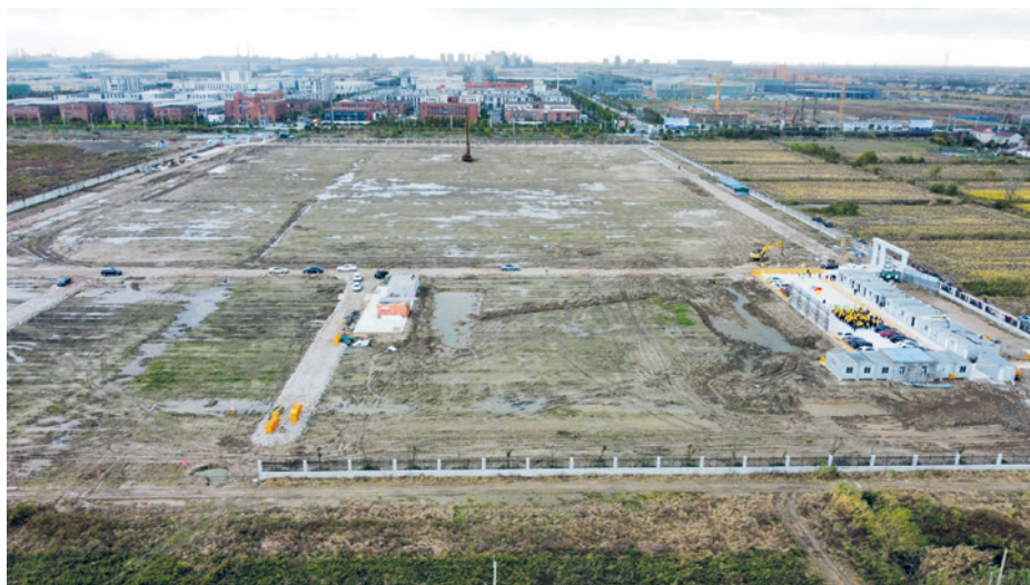
中国南通，设计产能为每年248万立方米砌块的加气混凝土（AAC）工厂正在建设中
