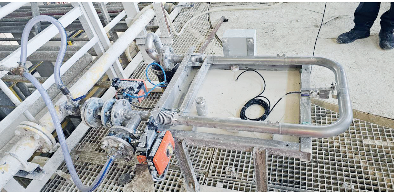
图2:土耳其现有工厂中的新一代泥浆密度测量装置
