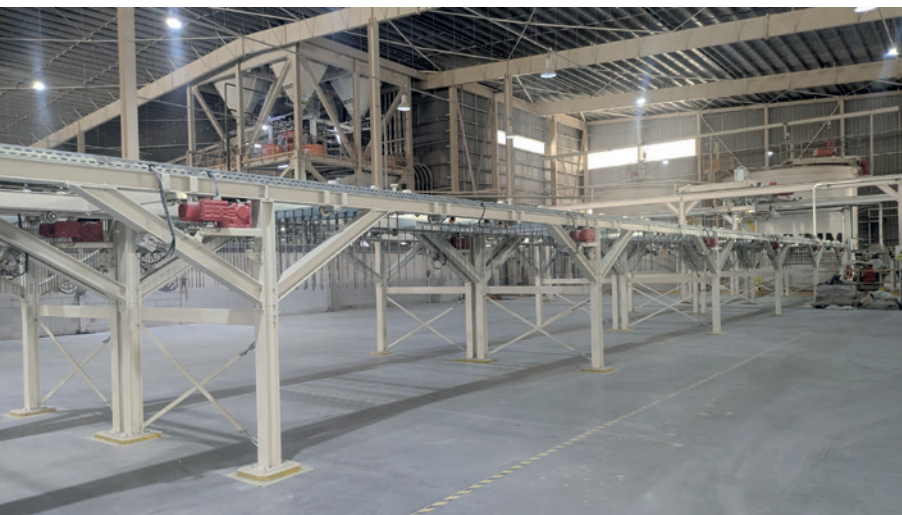
图5：带钢钎的钢筋固定架，在钢筋缓冲线上等待清洗
