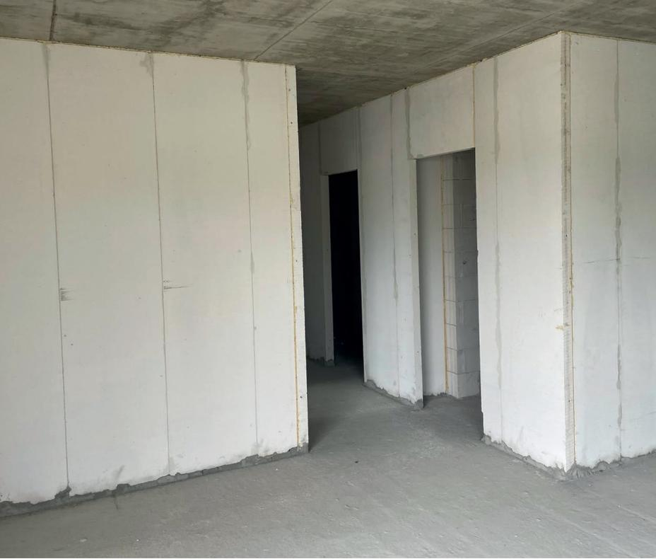
图4：波兰乌姆扎多户住宅中由模块化AAC墙板制成的隔墙
