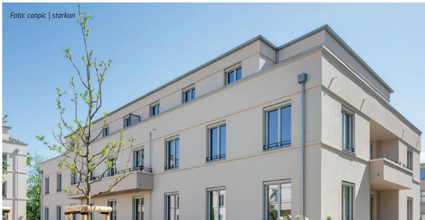
外墙采用Xella公司的Ytong蒸压加气混凝土，满足隔音、防火、隔热和结构稳定的高标准
