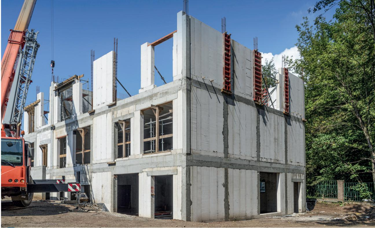
图3：使用模块化AAC墙板建造的波兰比托姆幼儿园
