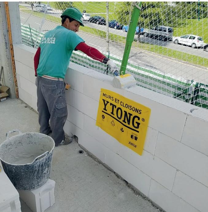
建筑物采用华丽的金属结构，外墙由HD Distribuciones提供的470平方米的Ytong厚度为20厘米（密度350千克/立方米）的墙体组成
