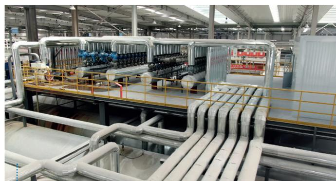
金隅陕西AAC生产基地采用蒸汽自动控制系统，充分利用蒸汽和余热
