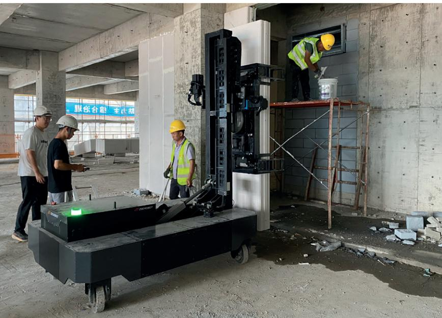
板材到达项目现场后，智能搬运机器人按楼层位置点到点精准配送、根据安装顺序有序摆放。智能安装机器人则按照施工规划同步进行板材安装，多机动态协作，最大限度提高施工效率和空间利用效率。
