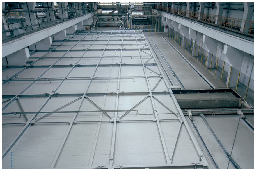
图3：新的恒温预养区已经全面覆盖，并配备了灵活的滚轮轨道系统
