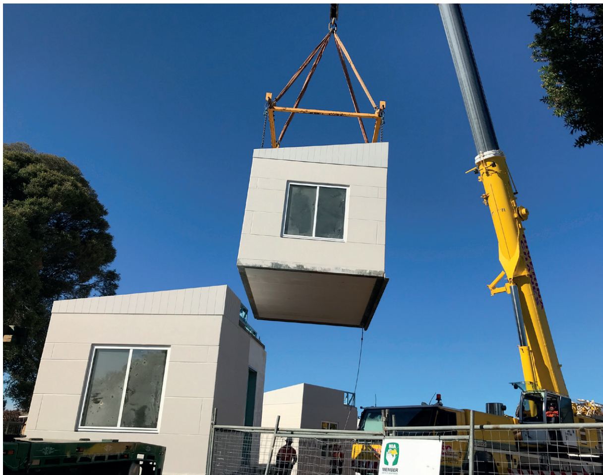
图9：模件直接从运输车辆上吊起并放置在钢墩上。（图片由建筑供应公司提供）
