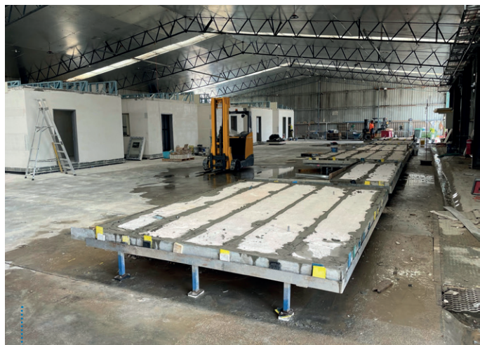
图4：模块是工厂秘密制造，包含过程质量控制程序。（图片由建筑供应公司提供）
