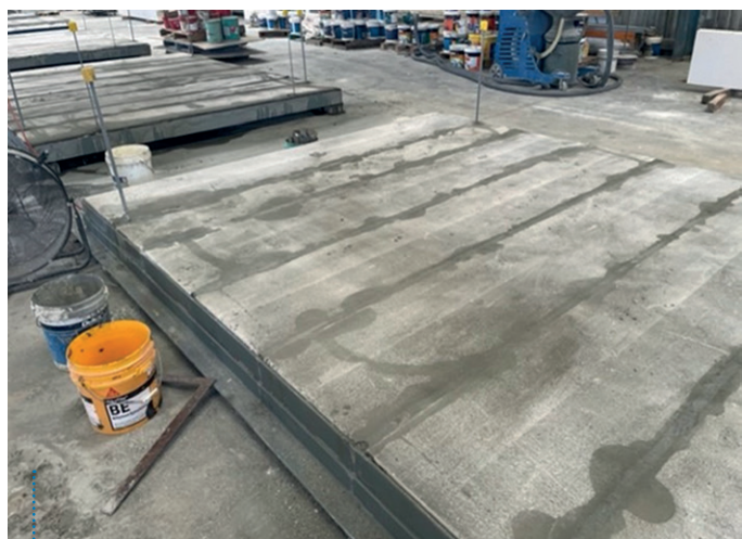
图5：正在组装地板组件。（图片由建筑供应公司提供）
