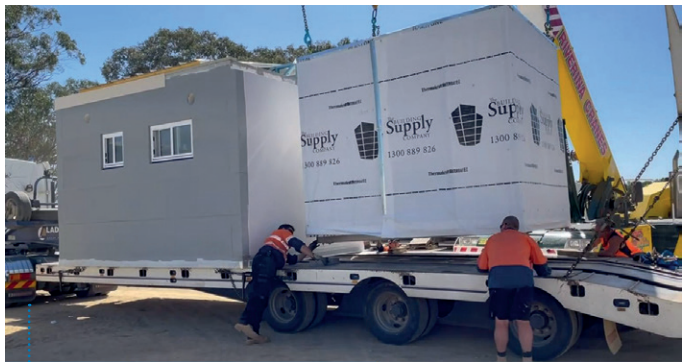
图8：模块正在装上卡车运往现场。（图片由建筑供应公司提供）
