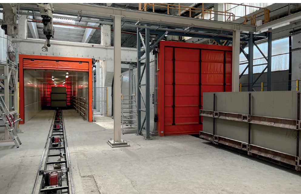
图9：新安装的恒温室，用于坯体釜前预养
