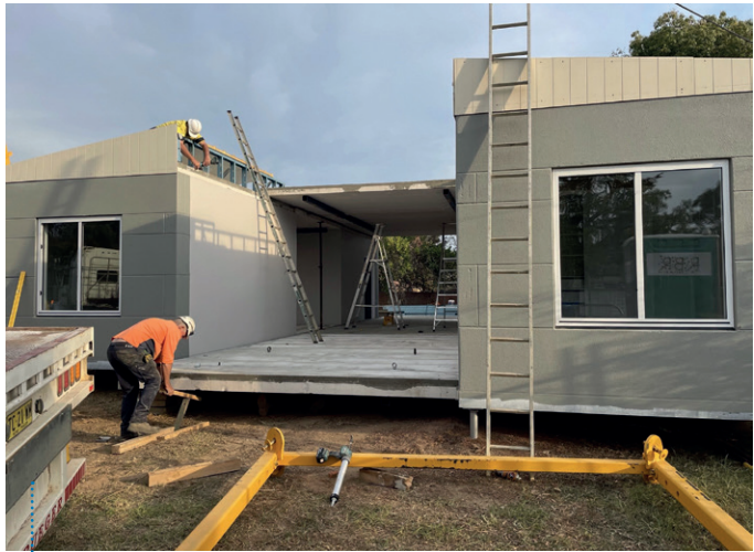
图7：天花板和地板的组件创造了主要的生活空间，并将所有的舱锁在一起。（图片由建筑供应公司提供）
