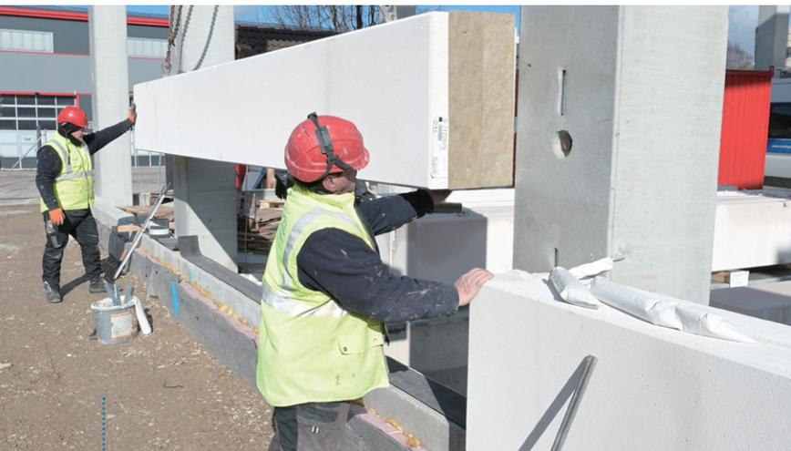
新大厅的建造应用了Hebel品牌钢筋加固的加气混凝土构件AAC 3.0/400 (Lambda 0,09)
