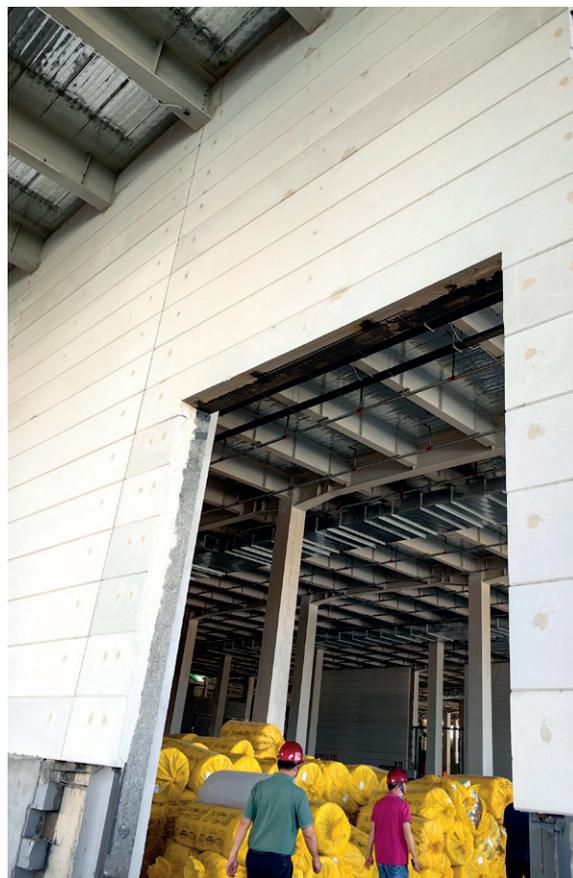
对于没有门窗的墙壁，面板应按顺序从主体结构的一端安装到另一端。当预期安装地点的墙板宽度小于一整块墙板时，应切割墙板，宽度应大于 200 毫米。
