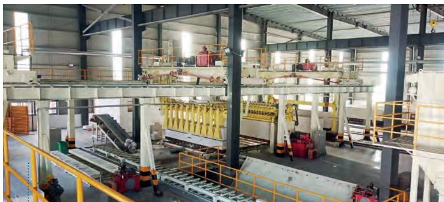
山东中昌开发建设集团有限责任公司正在 AAC 生产中使用黄金尾矿
