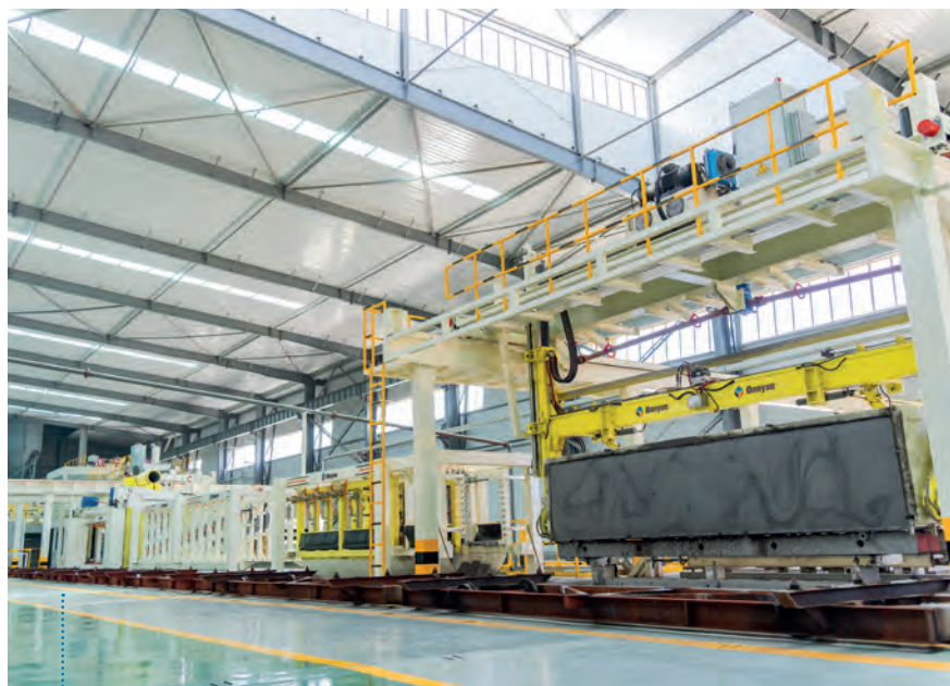
安徽马钢张庄矿业利用铁尾矿生产满足 A3.5 质量要求的 AAC 产品
