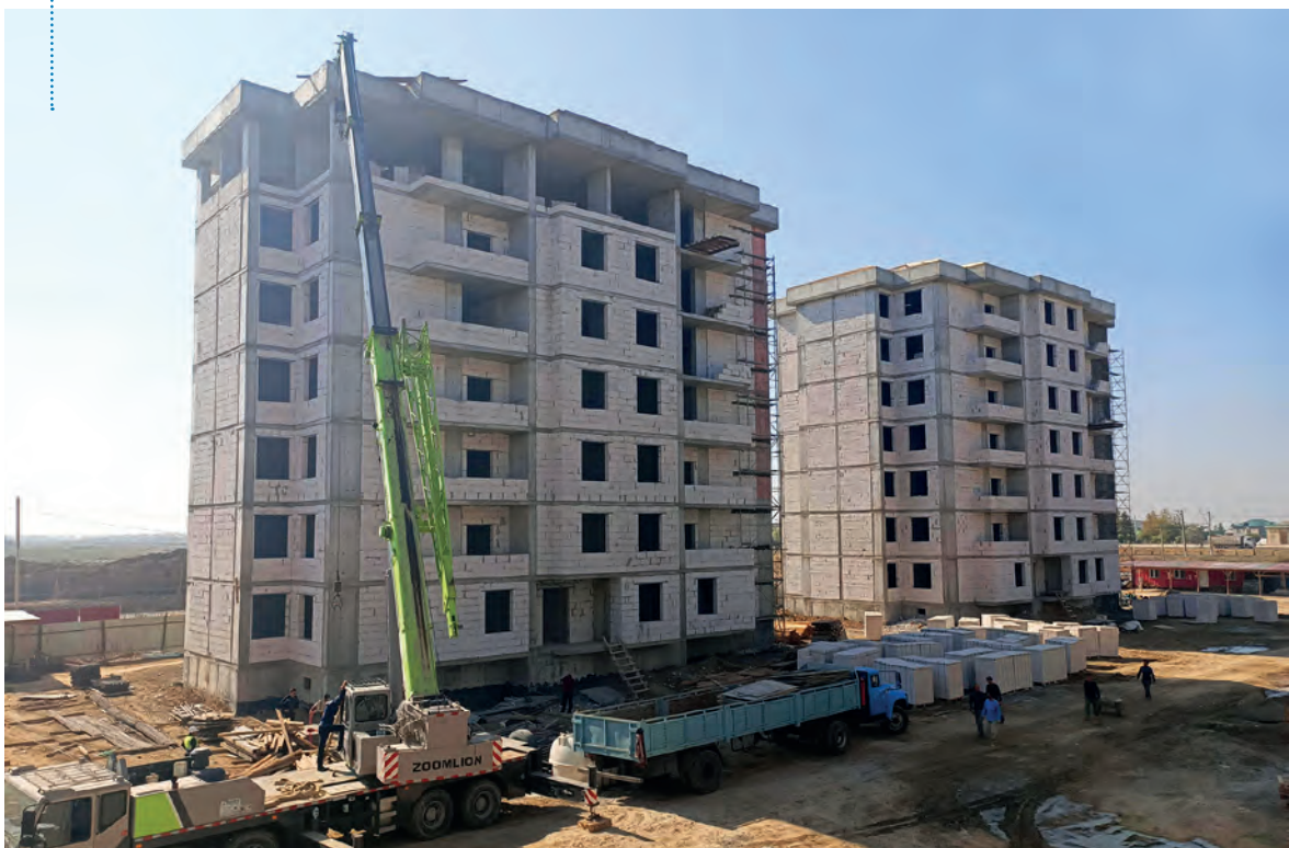
图 7: BS Group 在其位于乌兹别克斯坦古利斯顿市的项目中使用蒸压加气混凝土砌块
