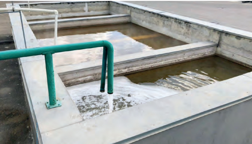
三段式梯级水池
