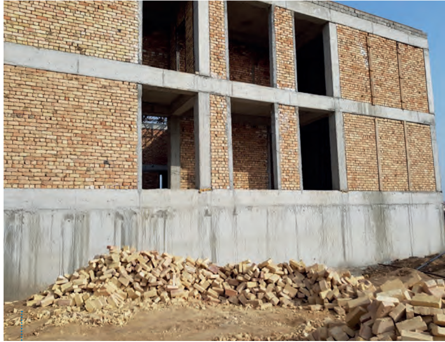
图 8：目前用红粘土砖建造的方法非常耗费人力，会留下很多废料并且需要额外加固
