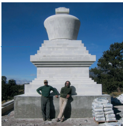
最后一个小立方体转接构件装配完成后，佛塔的壳体结构也基本成型。到目前为止，我们花了大约8周的时间来建造这个项目，包括每个部分钢筋布置和的注浆。
