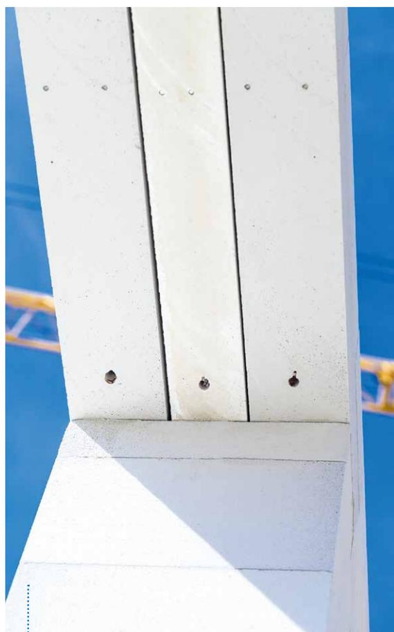
完全由 AAC 制成的外墙：通过使用 AAC 平檐梁，建筑公司以一种特别有效的方式，创建了一个有着均质表面及最小热桥值的外墙建筑。墙壁上的每扇窗和门都使用了三根总宽 42.5 厘米的平檐梁
