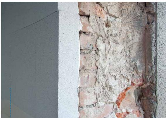
应用 Multipor 板材，隔热保温工程可以便捷地从建筑内部施工，从而保护历史建筑的墙体结构
