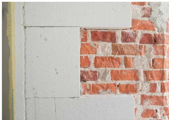
保温板材形制简易、重量轻便，操作毫不费力，即便在更加复杂的墙体结构上，也能精确地切割和拼接
