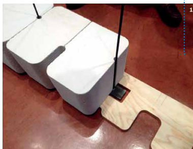
螺纹杆的底板和铣削通道
