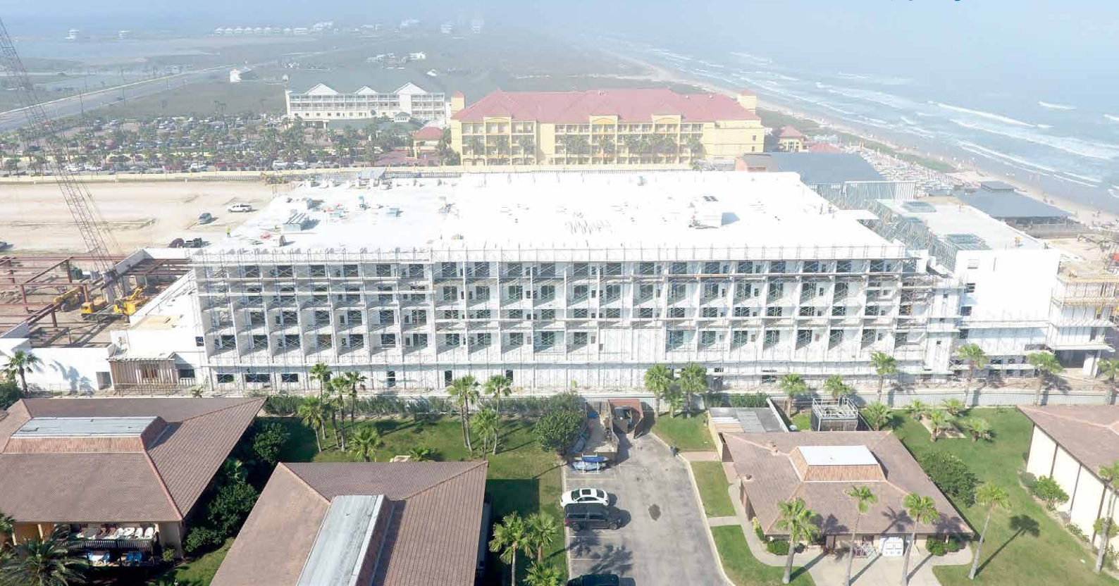
施工中的Courtyard酒店
