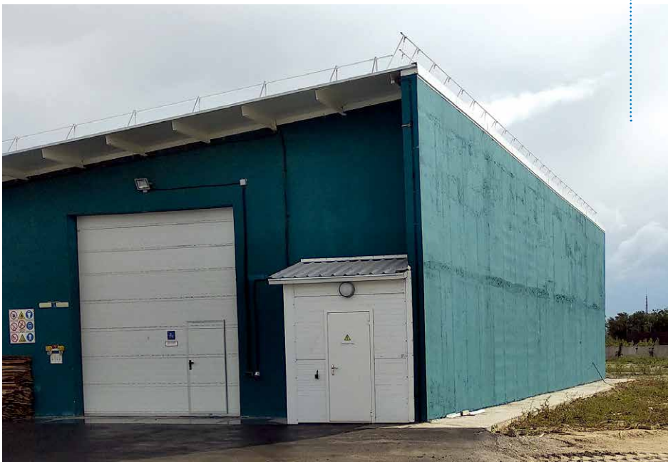
图5：储存铝膨胀剂的建筑物
