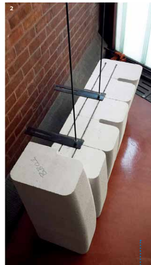
榫式墙式连接板和水平砌块加固
