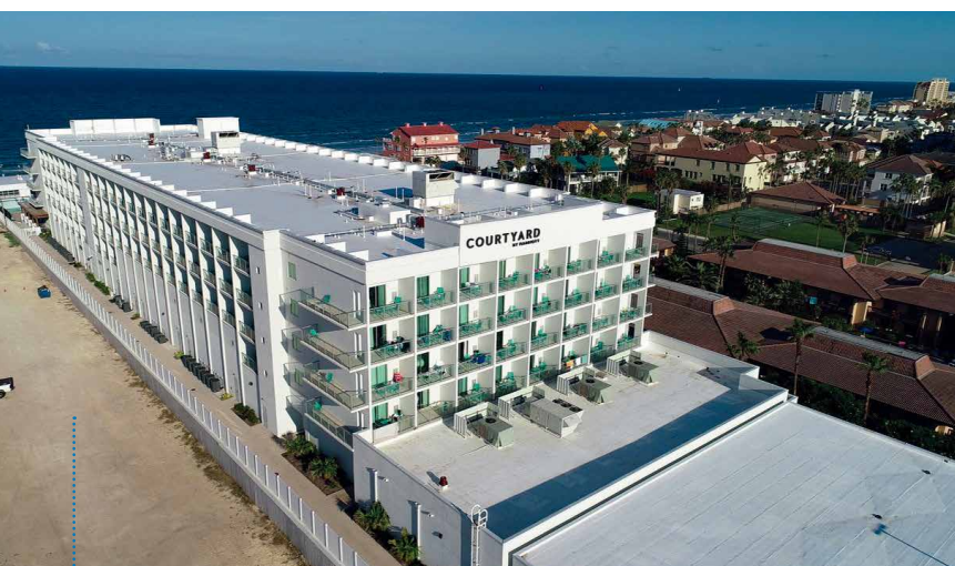
竣工状态的 Courtyard酒店
