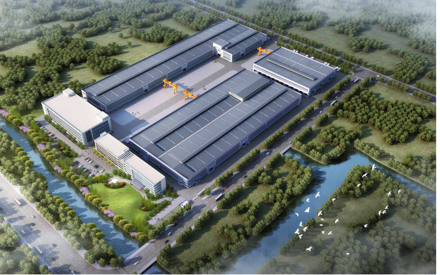
图15：绍兴工厂将成为中国现代化、自动化的AAC板材厂
