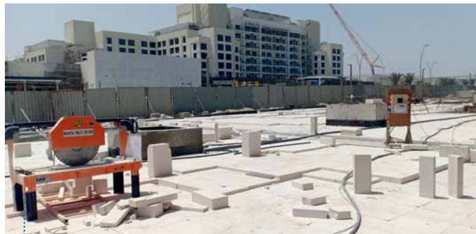
在现场安装的AAC块
