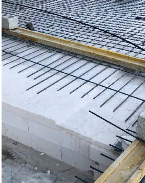
在阿拉伯联合酋长国首次将AAC用作空隙填充剂
