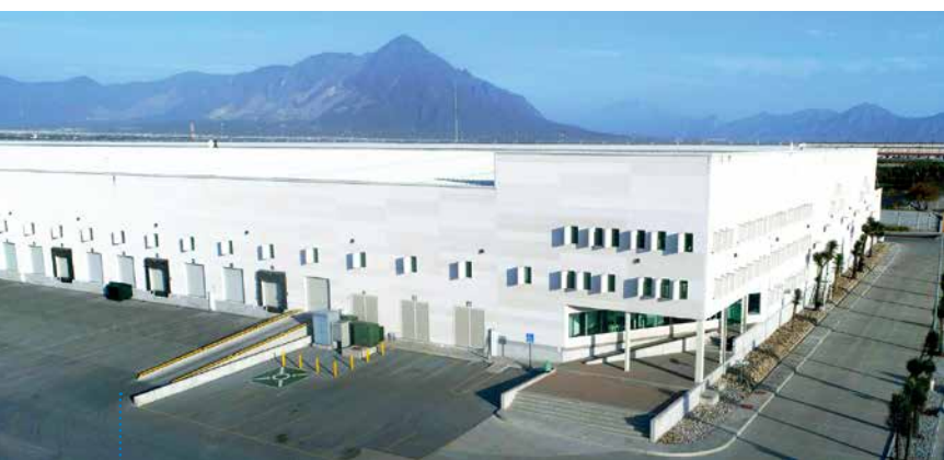
Puerta del Norte位于墨西哥新莱昂，它是一所面积达到41公顷的先进的多式联运物流园
